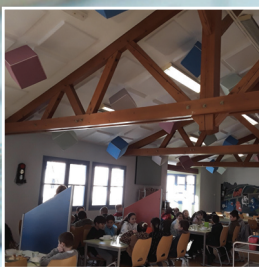
P.6 Rénovation du centre de loisirs
